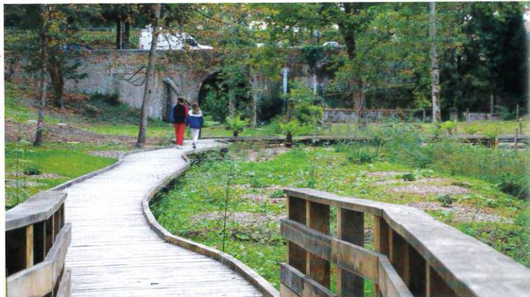
D'une longueur de 100 m et d'une largeur de 1,80 m, la passerelle en bois qui coure au fond du vallon est accessible aux personnes à mobilité réduite. Un chasse-roue, de section 15 x 15 cm, sécurise la traversée.
