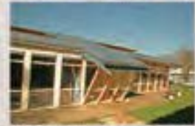
ASDER - Maison des Énergies CHAMBÉRY
